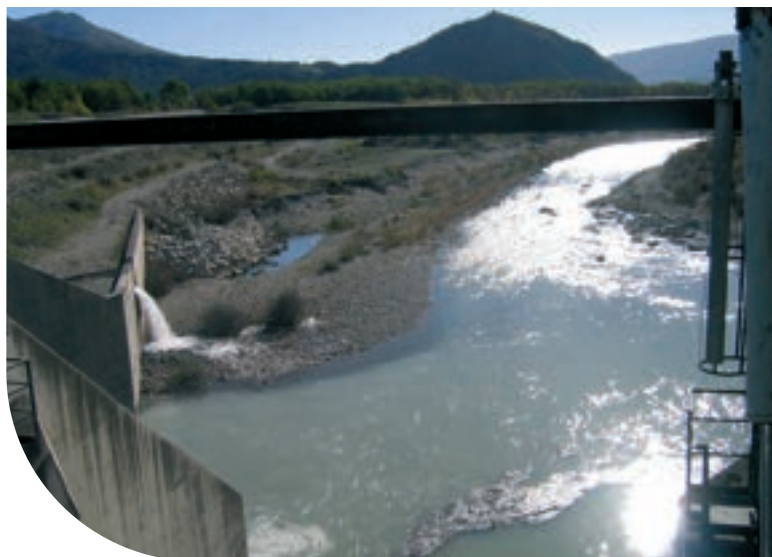
Buech - Barrage EDF Saint Sauveur
