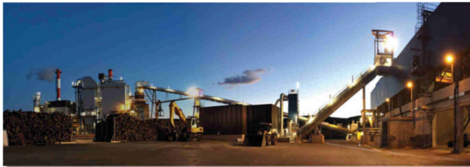
Centrale IVB à Brignoles (Var) 120 000 tonnes biomasse forestière PACA
